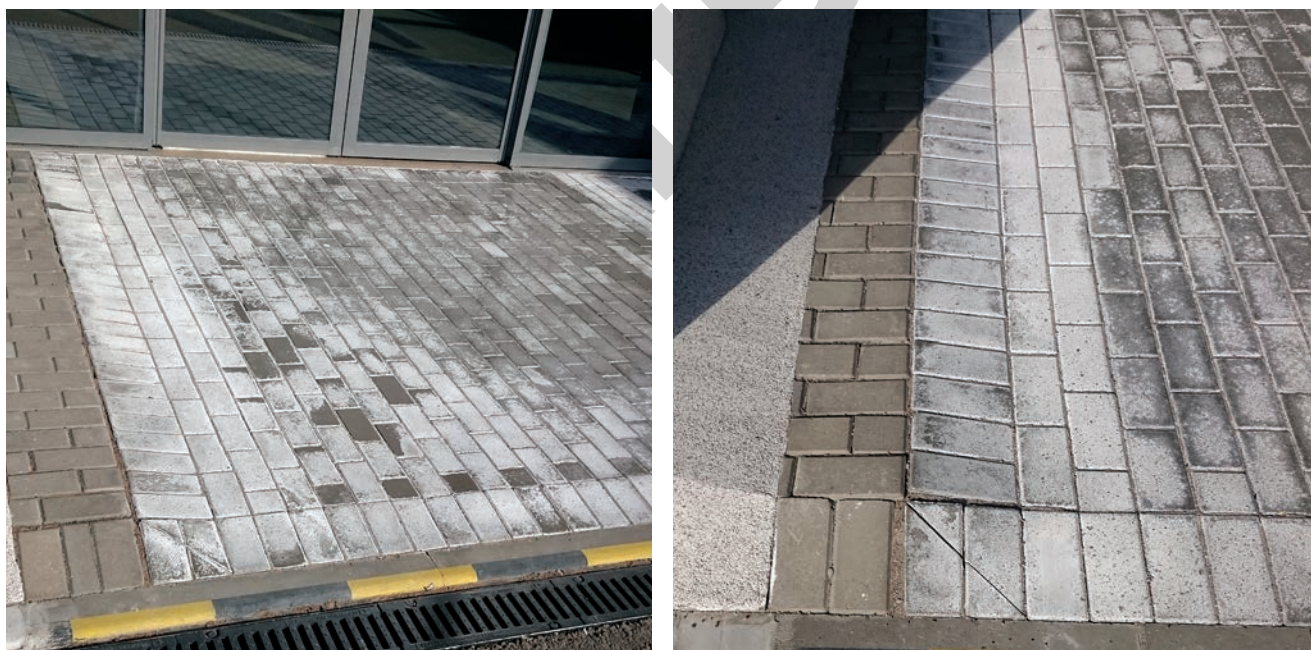
Рис. 10. Вторичные высолы на поверхности мощения.
