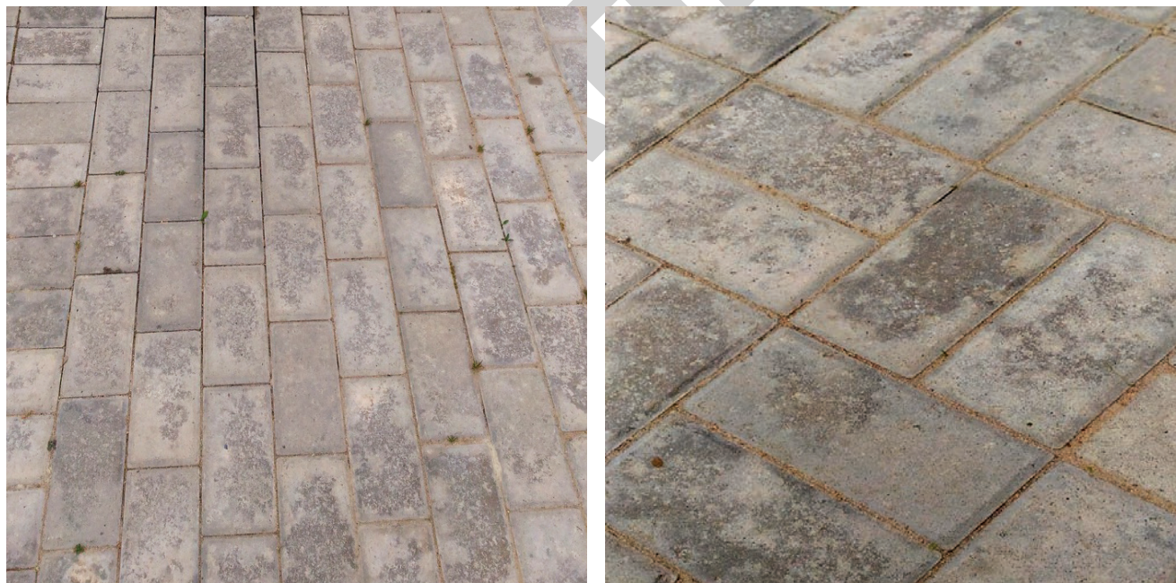
Рис. 10. Вторичные высолы на поверхности мощения.
